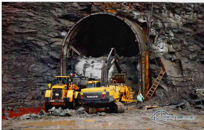
Второй Байкальский тоннель
