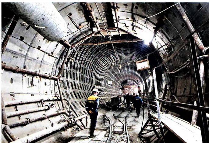
Строительство Лахтинско-Правобережной линии
