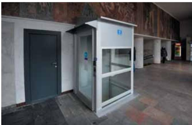
Рис. 2. Вертикальный подъемник на станции метро «Октябрьская» (<https://realt.onliner.by/2016/02/05/metro-podemnik?amp=1>)
