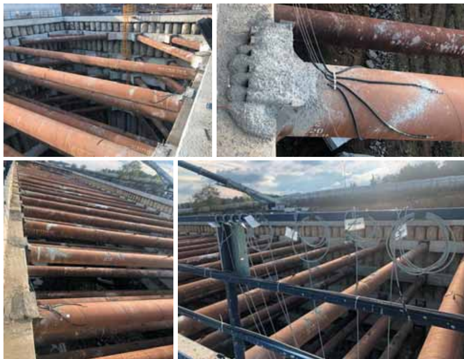
Рис. 1. Оснащение расстрельной системы котлованов датчиками в Турции, г. Стамбул
