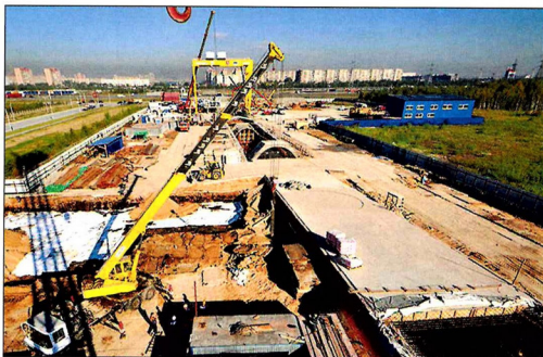
Строительная площадка станции метро «Южная» в Санкт-Петербурге
