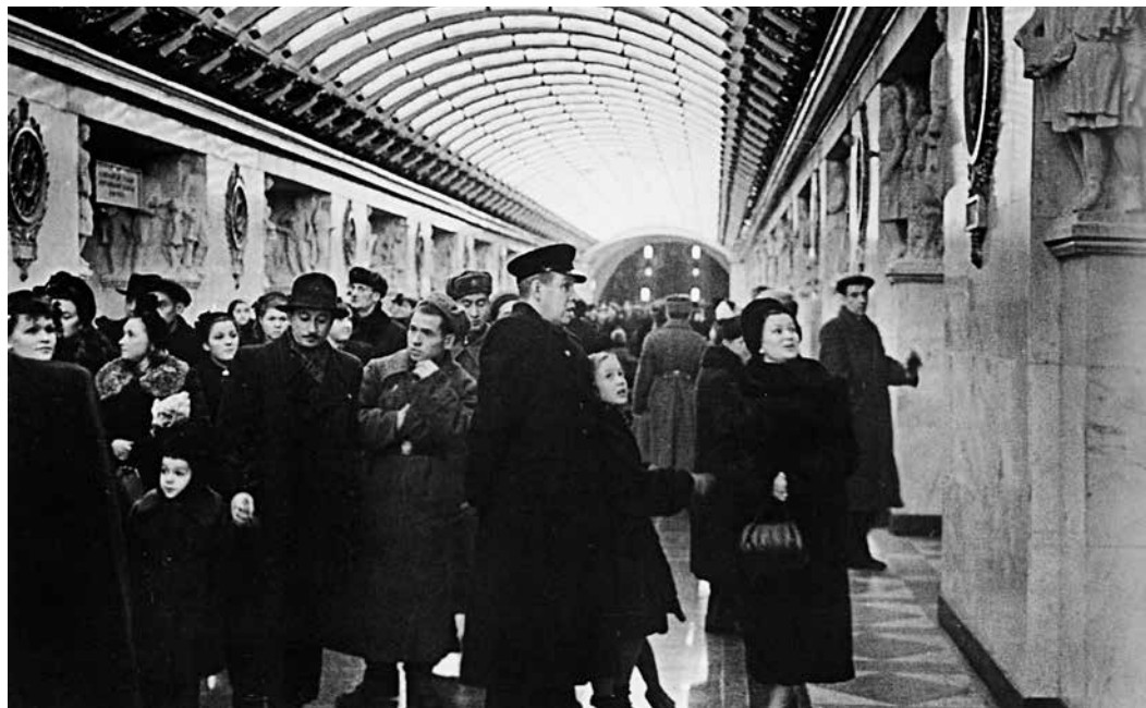
Станция метро «Нарвская». 1955 г.
