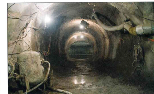
Применение набрызг-бетонных конструкций при строительстве горизонтальных тоннелей. Общий вид построенной вентсбойки
