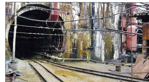
Строительство метро в Донецке
