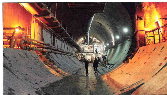
Двухпутный тоннель метро (Санкт-Петербург)
