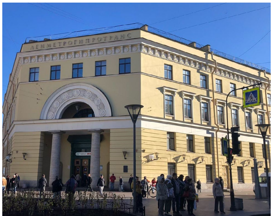
Рис. 1. Вестибюль станции «Владимирская» и здание ОА «Ленметрогипротранс»
