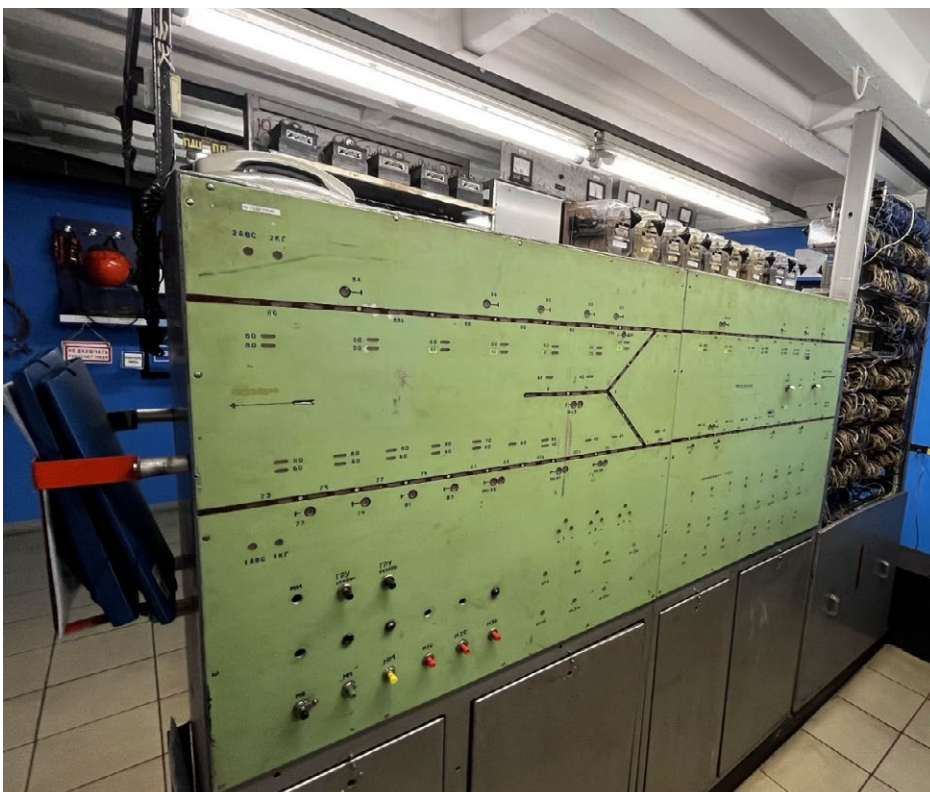
Рис. 2. Пример макета с кнопками диспетчера СЦБ в релейной АТДП
