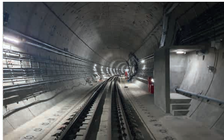
Новый Байкальский тоннель
