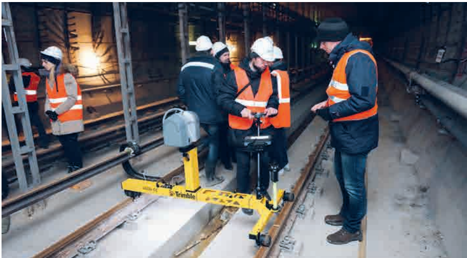
Лазерное сканирование тоннеля и определение параметров трассы и ВСП
