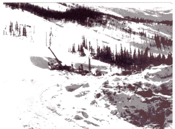
Рис. 5 Начало строительства западного portalного участка Байкальского тоннеля
