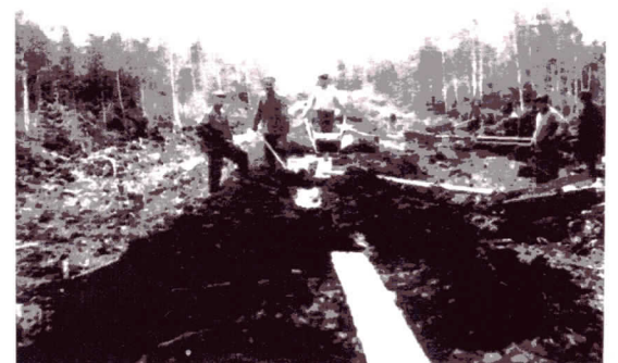
Рис. 2. Строительство подходов железнодорожных линий к магистрали. 1937–1940 г.г.
