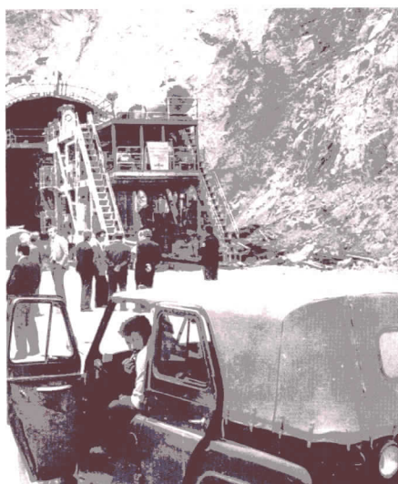
Рис.7. Врезка на Мысовом тоннеле №1
