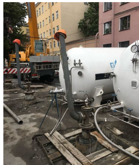
Рис. 1. Устье скважины на этапе дежурного наблюдения за показаниями температурных датчиков
